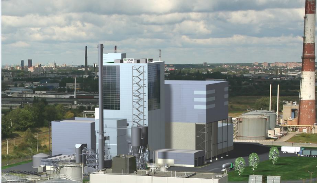
1 pav. Klaipėdos termofikacinės jėgainės bendras vaizdas
